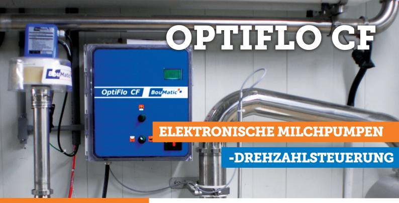
Elektronische Milchpumpen-Drehzahlsteuerung, die während des Melkens eine 3-Phasen-Milchpumpe unter Verwendung der neuen analogen Milchpegelsonde mit variabler Drehzahl steuert, sodass die Milch schonender transportiert wird.
